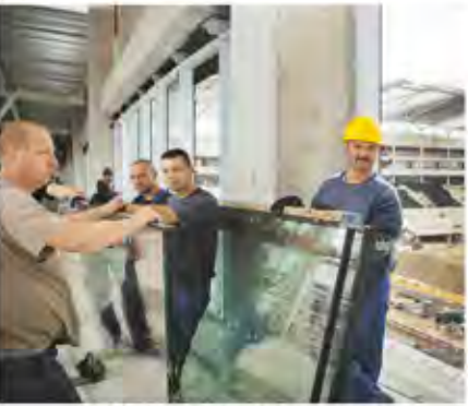
Arbeiders brengen een paar van de in totaal 18.115 vierkante meter glas aan.
