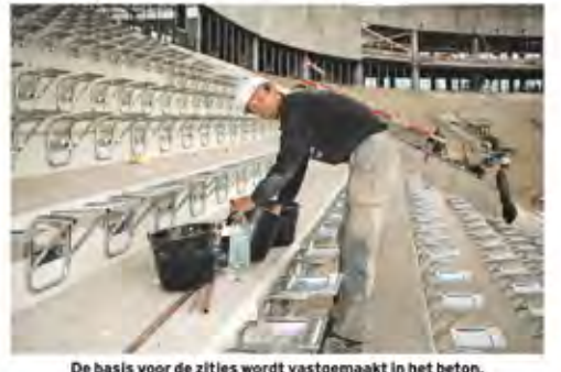
De basis voor de zitjes wordt vastgemaakt in het beton.
